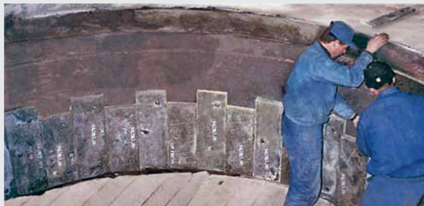
Proteção das tubulações de farinha crua contra desgaste pro atrito, utilizando o composto duro KALCRET, espessura de revestimento 25 - 40 mm, temperatura de uso 200 °C
