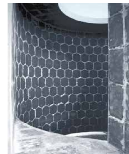
Expectativa de vida prolongada para equipamentos
