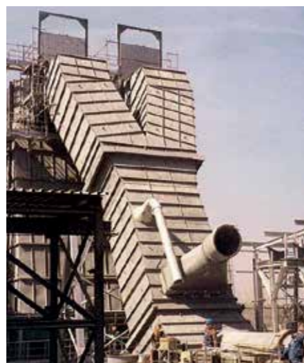
Revestimento da tubulação de escape do refrigerador KALCRET BNY
