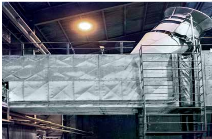
Proteção das tubulações de farinha crua contra desgaste pro atrito, utilizando o composto duro KALCRET, espessura de revestimento 25 - 40 mm, temperatura de uso 200 °C
