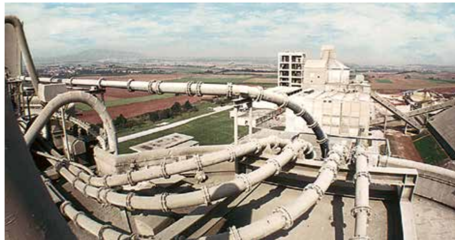
As tubulações na indústria cimenteira são protegidas de forma segura com ABRESIST, KALCRET ou, em casos de desgaste extremo, com KALCOR e KALOCER
