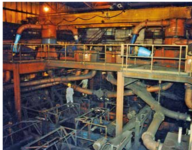
Tubos de transporte hidráulicos no processamento de carvão na América do Norte. O revestimento dos tubos é feito com ABRESIST. A vida útil, nesse caso é superior a 20 anos.
