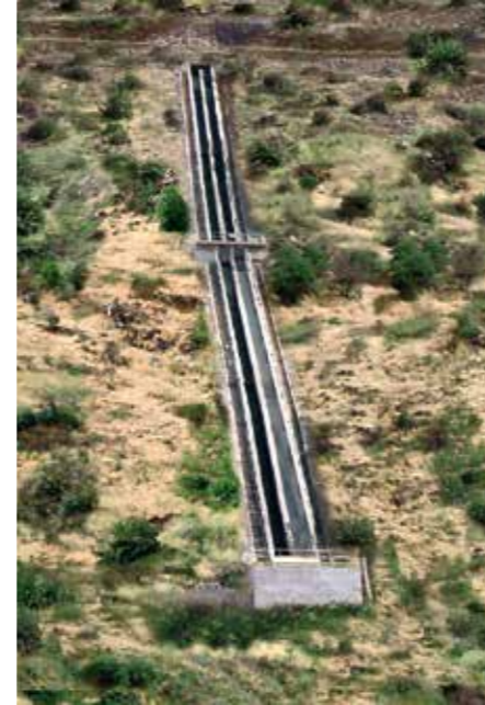
Canais hidráulicos por gravidade só apresentam desempenho duradouro quando operados com o revestimento adequado. Nesses casos, o basalto fundido ABRESIST é a solução ideal para obter longa vida útil.
