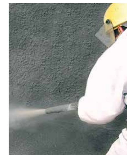
A assistência da Kalenborn resolve problemas de desgaste no local
