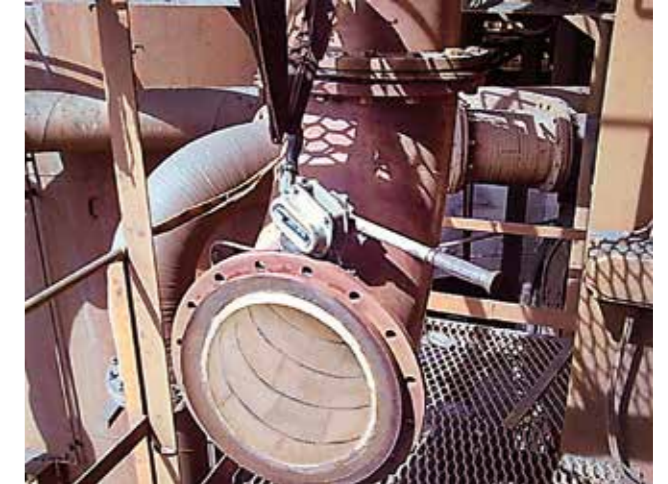
Tubos protegidos com zircônio corundum KALCOR na área de saída de um moinho de minério de ferro no Brasil. Enquanto os revestimentos de borracha duraram por pouquíssimo tempo, o revestimento em KALCOR permanece em operação por vários anos.
