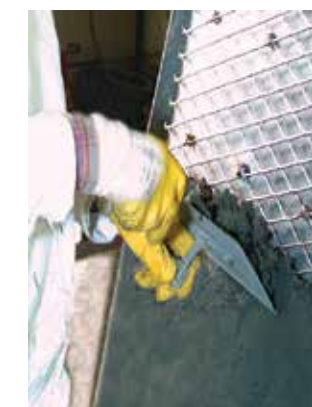
Hoje em dia, os separadores também são frequentemente protegidos com solda dura por deposição KALMETALL ou composto duro KALCRET, sem juntas (fotos)
