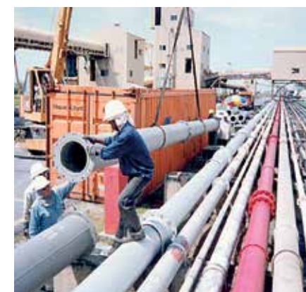
Montagem de um tubo de cinza úmida (com diâmetro de 350 mm) na Malásia
