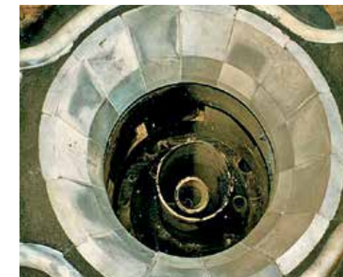
Proteção de queimadores de carvão em pó com KALSICA N ou KALMETALL
