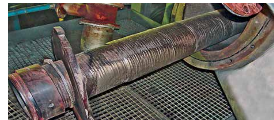
Queimador de carvão com reforço de KALMETALL
