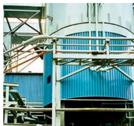
O calcário para sistemas REA pode ser bastante abrasivo: o material para revestimento é o ABRESIST
