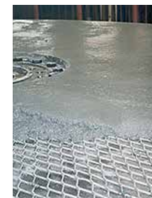
Hoje em dia, os separadores também são frequentemente protegidos com solda dura por deposição KALMETALL ou composto duro KALCRET, sem juntas (fotos)
