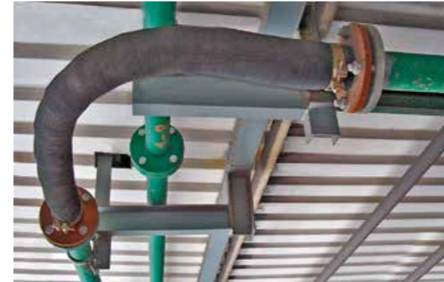
Curvas de tubo KALFLEX na operação prática; aqui como conexão flexível entre pontos de fixação fixos
