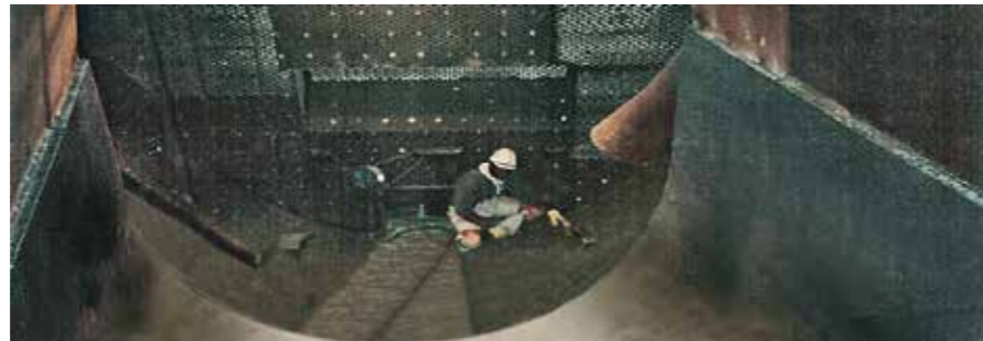
Eficácia comprovada em canais de granulação de escória: Composto duro KALCRET
