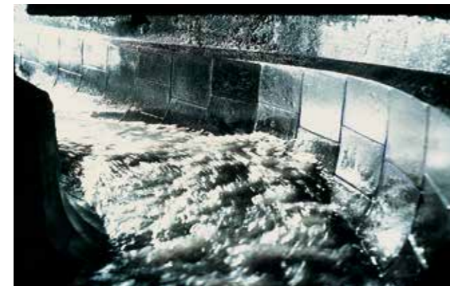
Os canais de carepa são eficientemente revestidos com basalto fundido ABRESIST
