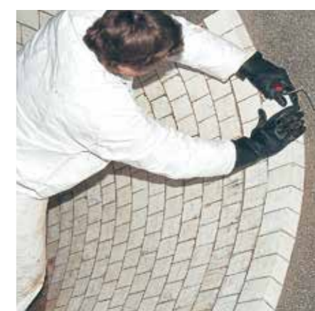
A assistência da Kalenborn resolve problemas de desgaste no local
